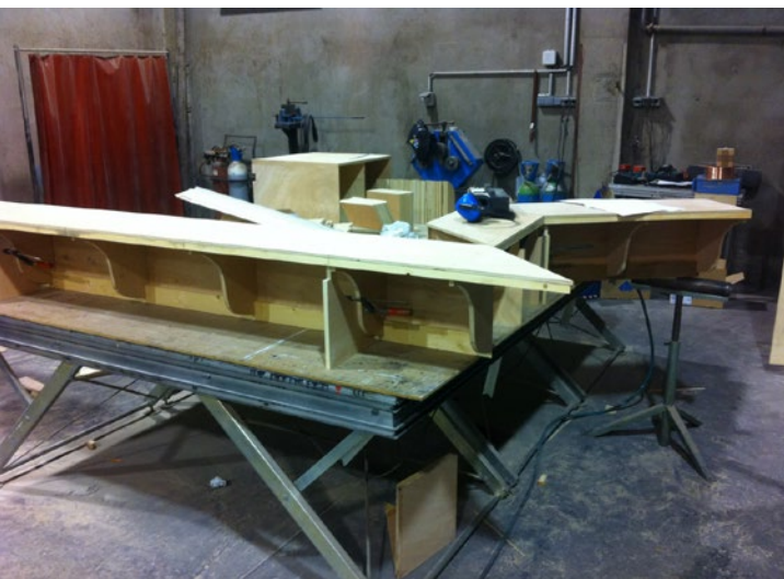
1, 2 : Construction du décor © CDN Nancy Lorraine
